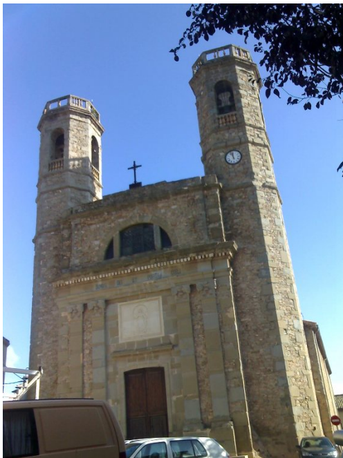
Abbildung 9: Auf dieser Kirche sind Wlan-Antennen montiert (nicht im Bild).
